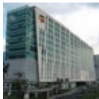
Edificio Bancolombia, Ecoroofing
